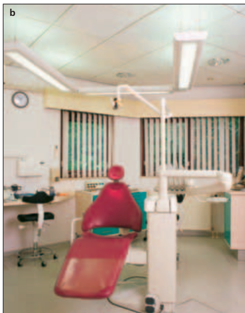
Afb. 4a en b. Het verschil tussen een niet en een wel gelijkmatig verlichte verlichting van de praktijkkamer, waarin verder lichte kleuren zijn gebruikt. Door pendelarmaturen, die minstens 40 cm beneden het plafond hangen, worden zowel het beneden- als het bovengedeelte van de praktijkkamer in verhouding met elkaar gelijkmatig verlicht.
