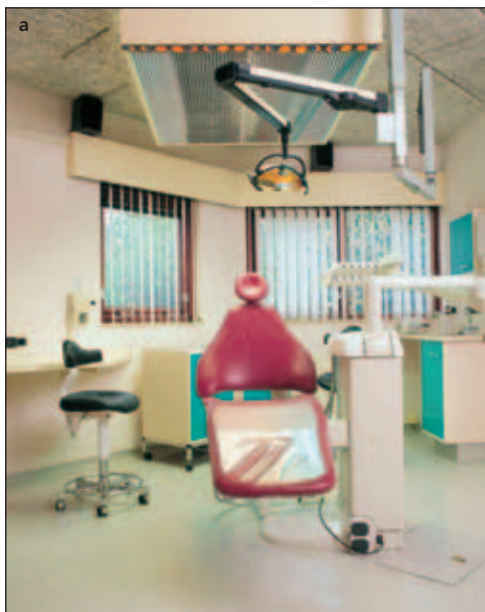
Afb. 4a en b. Het verschil tussen een niet en een wel gelijkmatig verlichte verlichting van de praktijkkamer, waarin verder lichte kleuren zijn gebruikt. Door pendelarmaturen, die minstens 40 cm beneden het plafond hangen, worden zowel het beneden- als het bovengedeelte van de praktijkkamer in verhouding met elkaar gelijkmatig verlicht.
